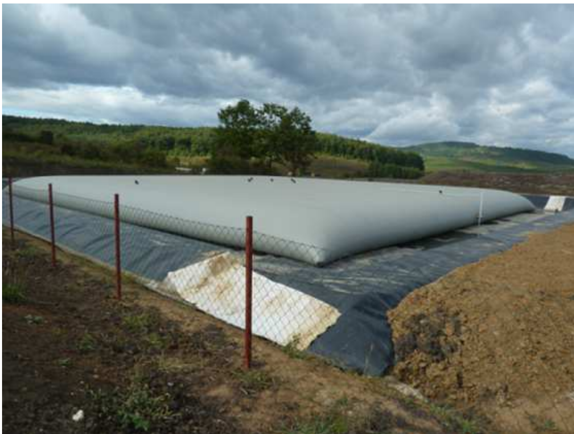
14. kép A feltöltött flexibilis tartály a szigetelt földmedrű medencében
