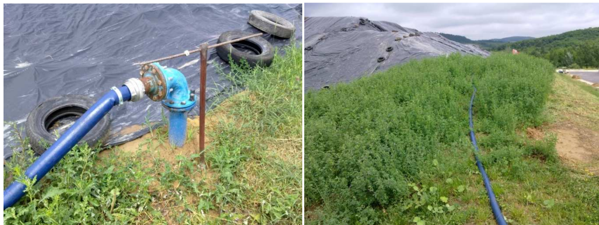
15. kép: Flexibilis töltővezeték csatlakoztatása a vízvételi pontra és fektetése a határoló gát koronáján
