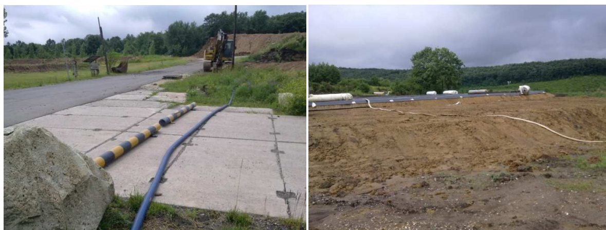
16. kép: Flexibilis töltővezeték átvezetése a betonúton, a védelmét szolgáló, behajtást gátló festett acélcsővekkel, valamint fektetése a vésztározó mellett és határoló gátján át
