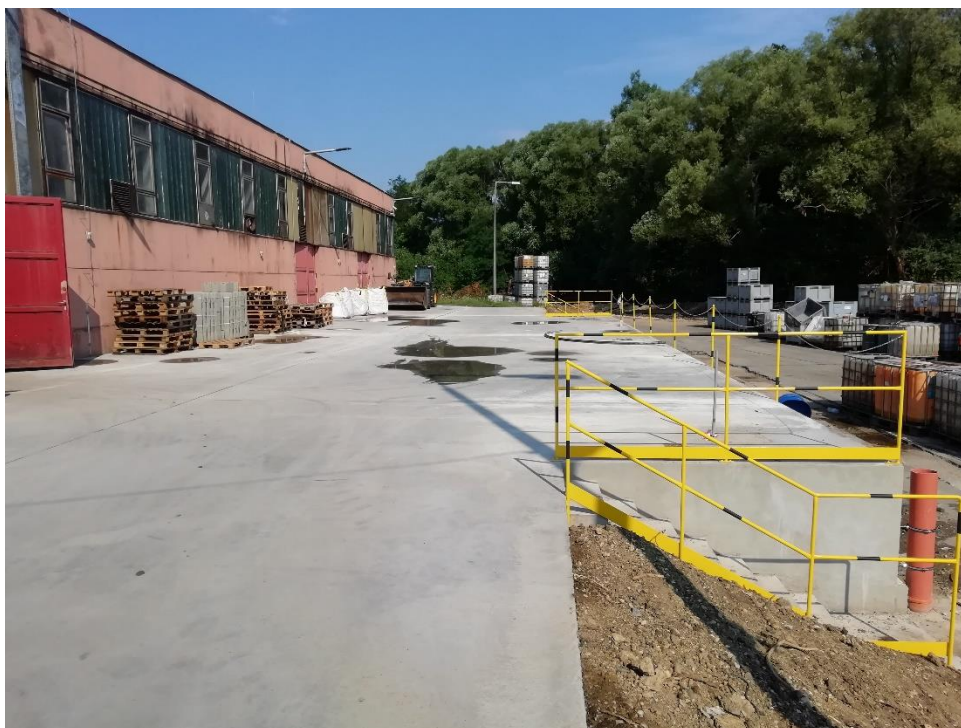
9. Ábra: Betonozott árufogadó rámpa
