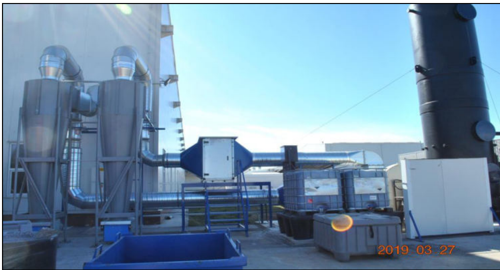
2. kép: Az északi homlokzat elé épített gázmosó berendezés
