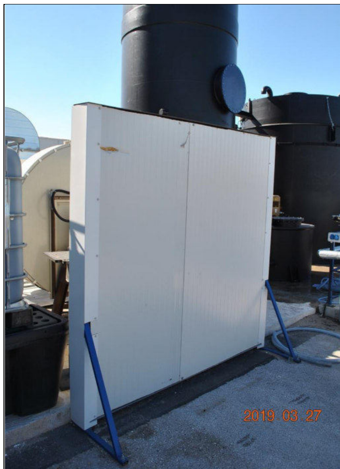
8. sz. kép: Zajgátló fal a gázmosó radiális ventilátora előtt
