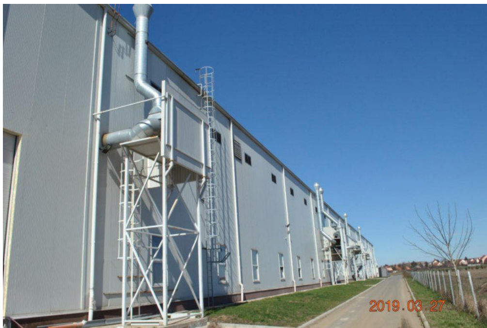
3. sz. kép: Csarnok keleti oldal, kifúvók a zajcsökkentő paravánok megépítése után
