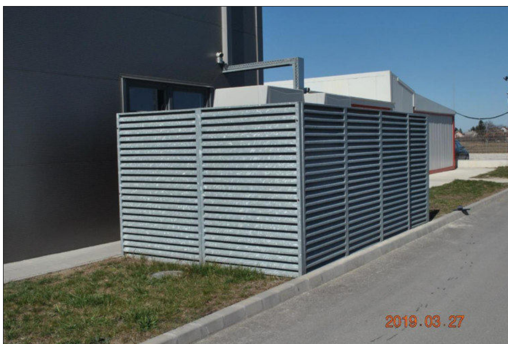
11. sz. kép: Zajvédő paraván az iroda légkezelőjének kültéri egysége körül
