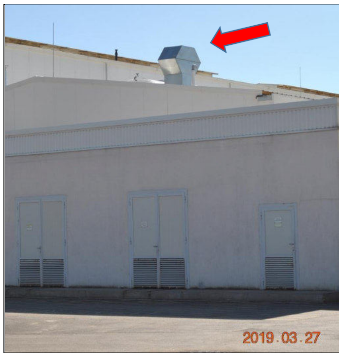
9. sz. kép: Hangelnyelő burkolat a tetőkifúvón
