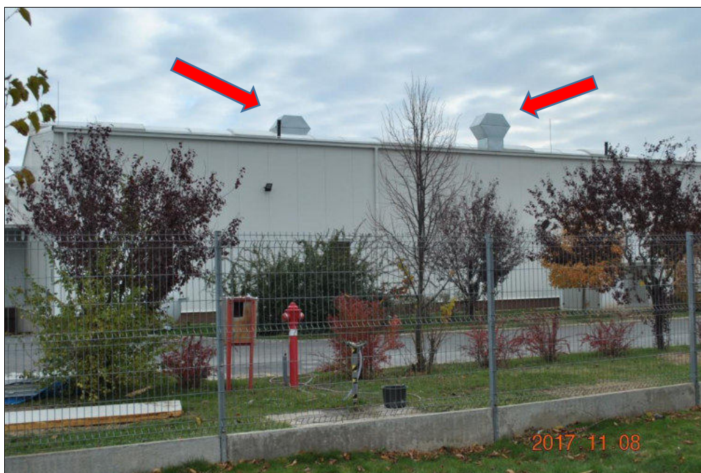
10. sz. kép: Hangelnyelő burkolat a tetőkifúvókon
