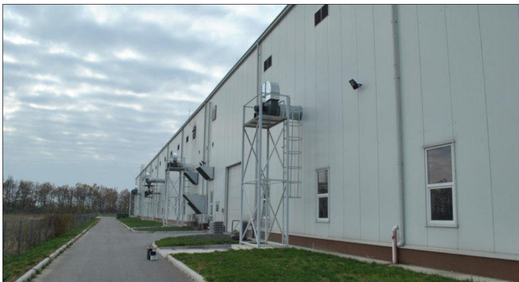
1. sz. kép: Csarnok keleti oldal, kifúvók a zajcsökkentő paravánok megépítése előtt
