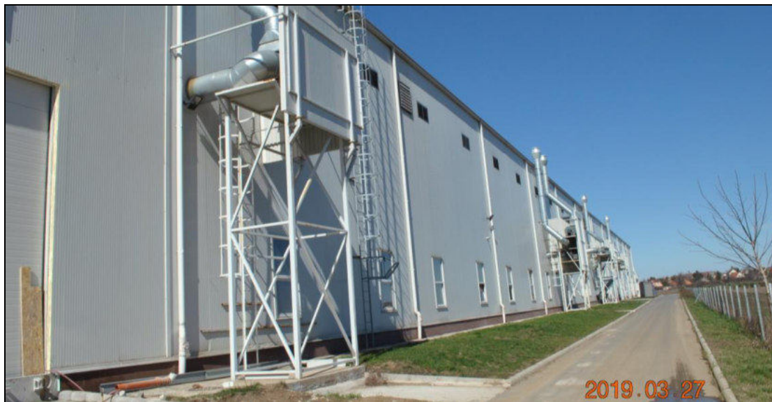
6. sz. ábra: A keleti homlokzat kifűvői
