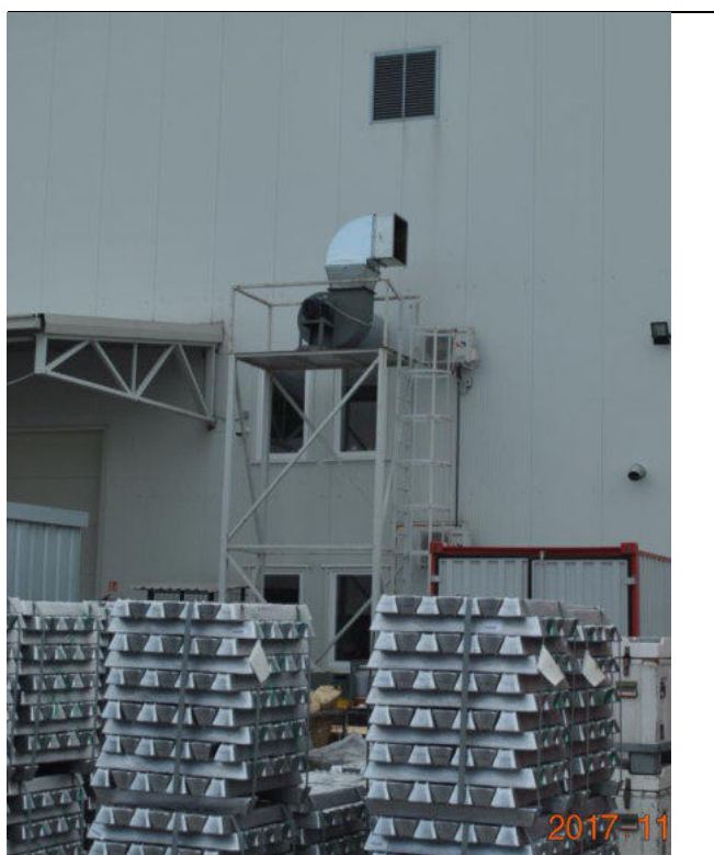
4. sz. kép: Radiális ventilátor a csarnok északi homlokzatán paraván nélkül
