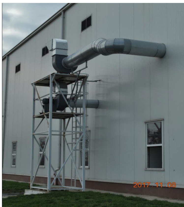
2. sz. kép: Radiális ventilátor és kifúvó csomak a zajcsökkentő paraván megépítése előtt
