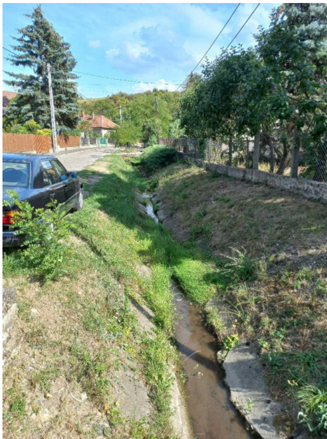
17. kép) Mederrészlet megrongálódott mederelemekkel a 'BÁ-1' jelű szakaszon
