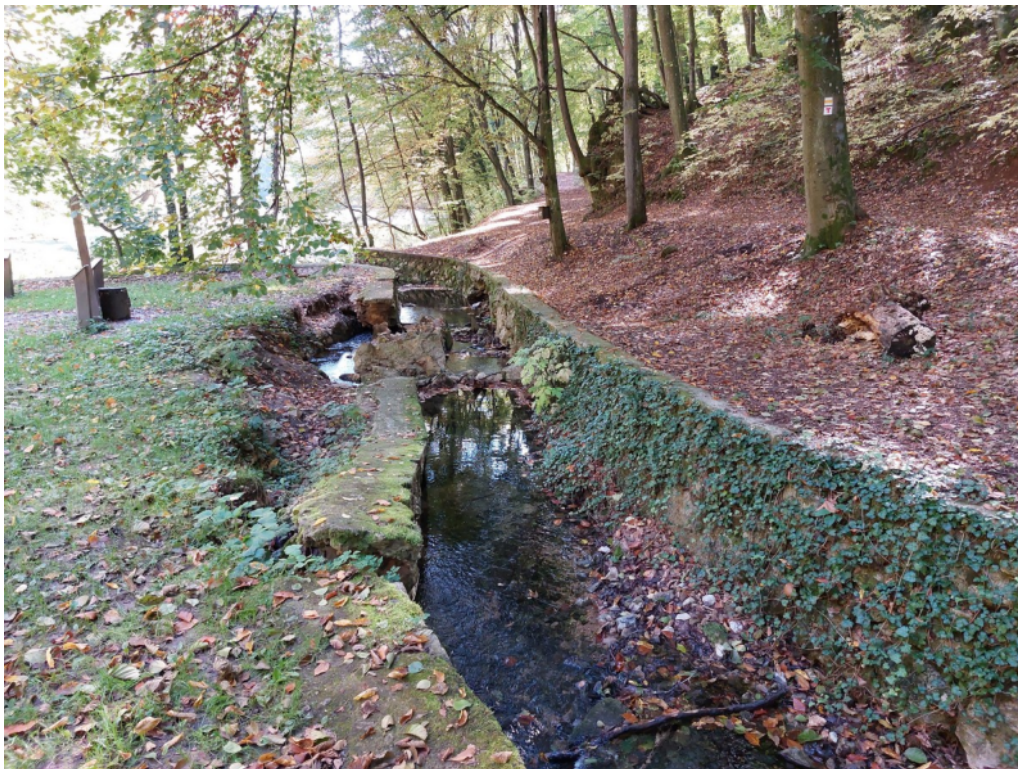
4. fénykép: egyes szakaszok rekonstrukcióját lehetőség szerint munkagödörből kell elvégezni, a meder érintése nélkül
