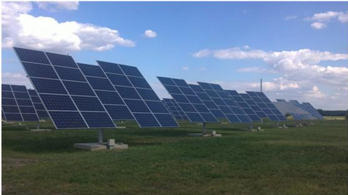
2.8-1. ábra: Az újszilvási naperőmű (napkövető, forgatható tartószerkezetes típus)
