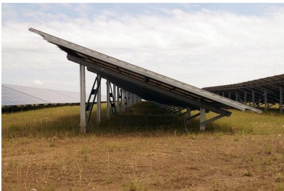
2.1.2.1-3. ábra: A napelem táblák tartószerkezete (Visonta)
