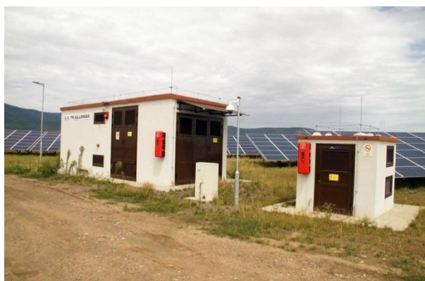
2.1.2.1-4. ábra: A napelem táblákból kialakított sorok között elhelyezett konténerek (Visonta)
