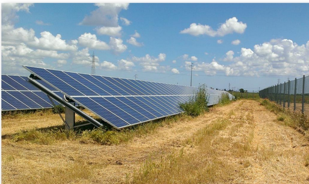
2.5.1-3. ábra: A magasra növő növények a napelemeket leárnyékolják
