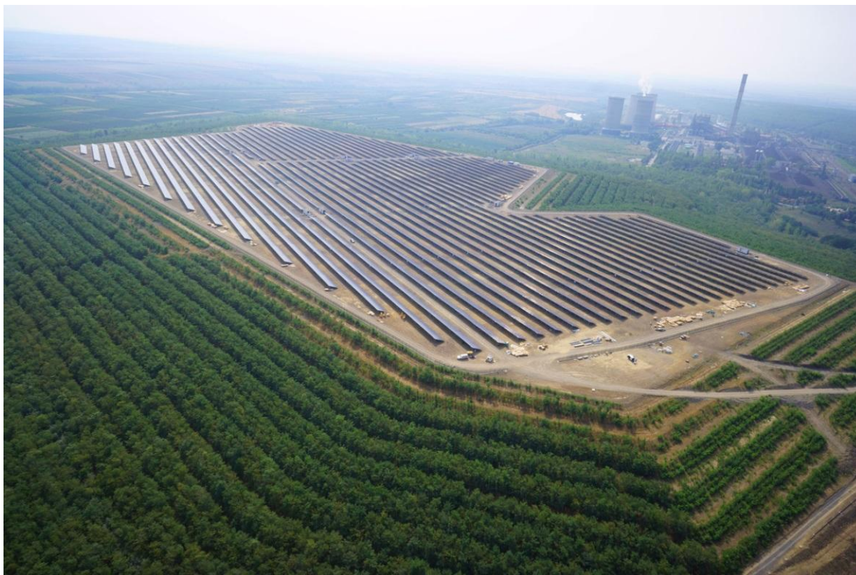
2.8-3. ábra: A Mátrai Erőmű ZRt. visontán, az Őzse-völgyi felhagyott, rekultivált zagyterén megvalósult 16 MW-os naperőműve
