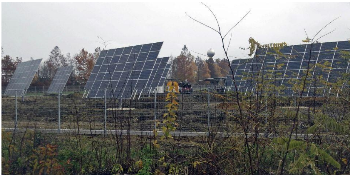
2.8-2. ábra: A Sellyén létesített naperőmű (napkövető, forgatható tartószerkezetes típus)
