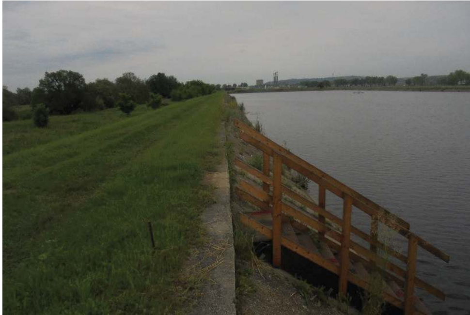
5. ábra Egy beton szegélyű ülepítőmedence
