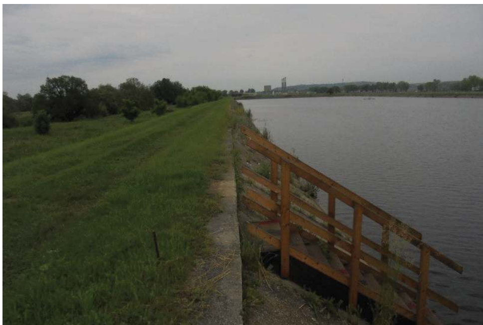
9. ábra: Egy beton szegélyű ülepítő medence
