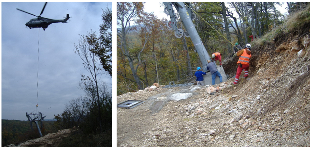
35. ábra: A tartóoszlopok beemelése helikopterrel
