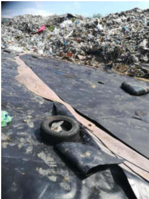
3. fénykép Beépítendő panel beillesztése
