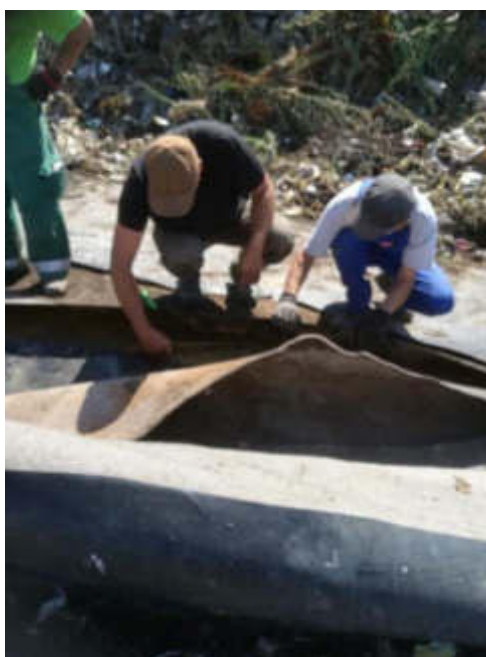
2. fénykép KBFI-TRIÁSZ Kft. érzékelő pontok ellenőrzése-javítása
