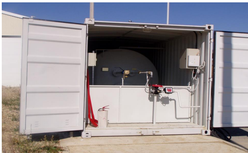
4. kép: Az üzemanyag tároló tartály, előtte a konténerházhoz folyadék-tömören kapcsolódó acél válaszfallal, illetve a szerelvényekkel
