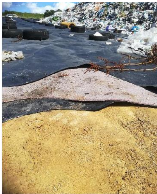
3. kép: A lerakó aljzatszigetelő fóliájának sérült része (Zöld Völgy Nonprofit Kft.)
