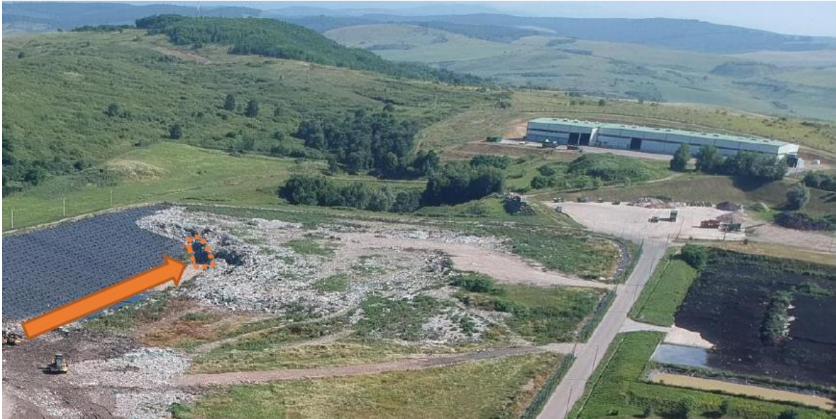
2. kép: A lerakó medence sérült része (Zöld Völgy Nonprofit Kft.)
