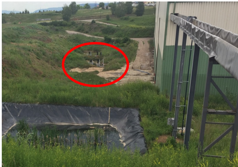
8. ábra: Csurgalékvíz gyűjtő, -ellenőrző, valamint biztonsági szivárgó drének kivezetései
