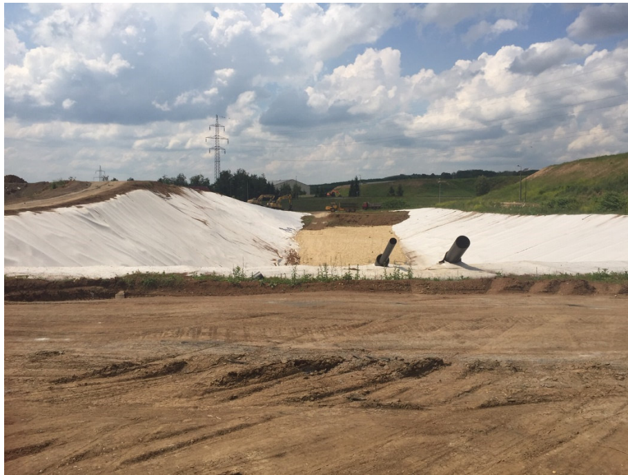
9. ábra: A III. ütem szekunder és terciér szivárgóinak kivezetései
