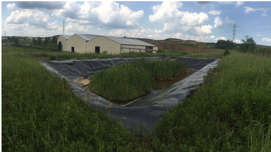
12. ábra: A CsA-1 jelű csapadékvízgyűjtő medence
