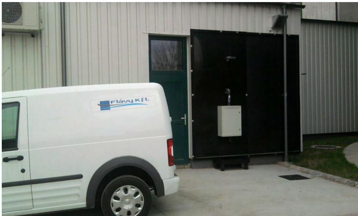
24. ábra: A vas(III)-klorid tartály vezeték külső csatlakozása (szekrény) és alatta a cseppfogó
