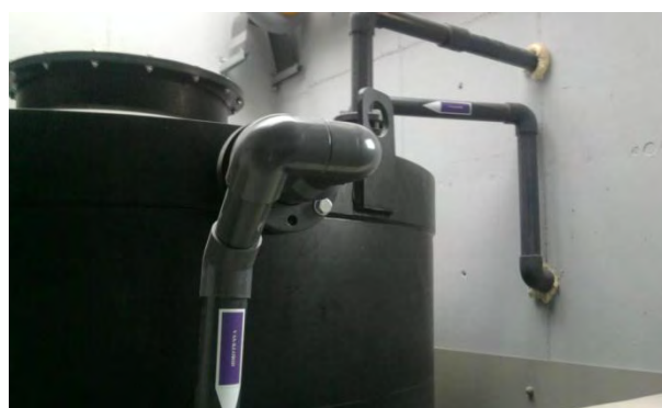
23. ábra: A töltő vezeték
