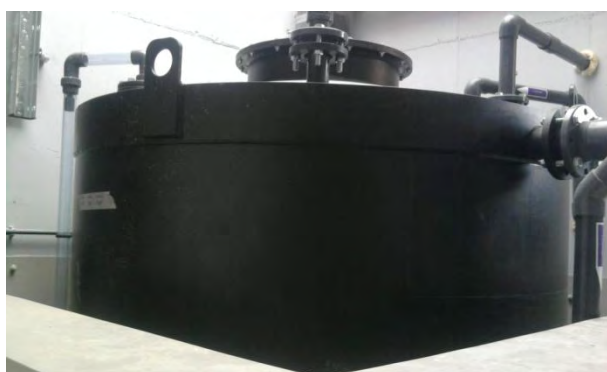
22. ábra: A vas(III)-klorid tartály és a kármentő
