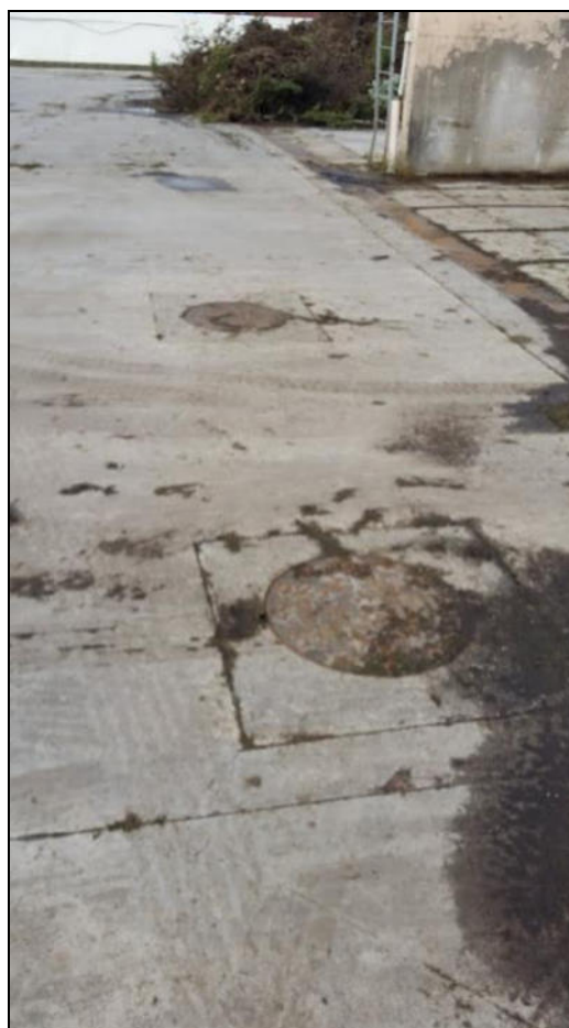
6.3. kép: Csurgalékvíz gyűjtő tartályok fedlapjai
