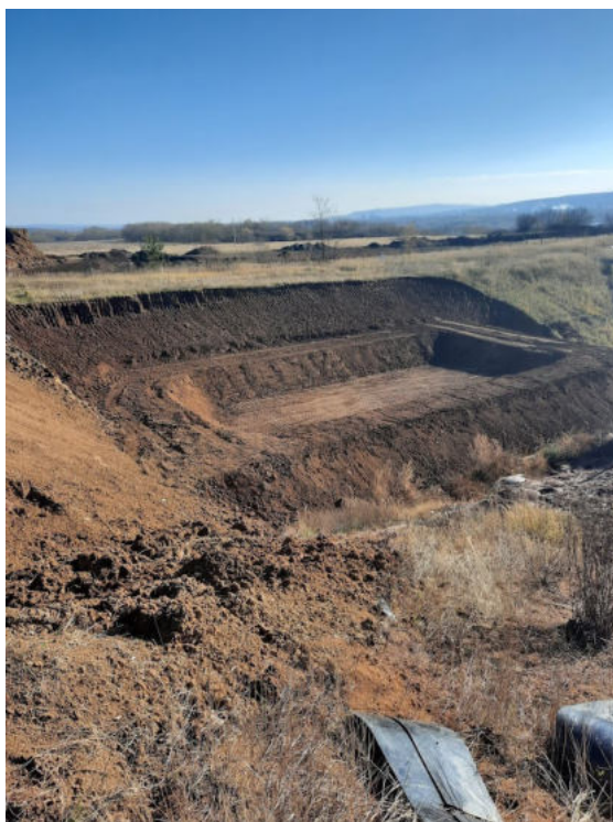
14. ábra A csurgalékvíz-medence építése_1
