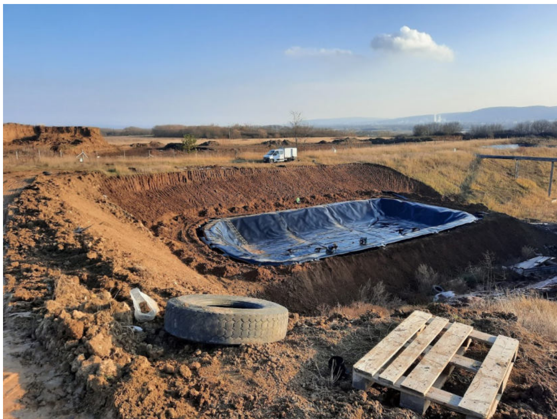
15. ábra A csurgalékvíz-medence építése_2
