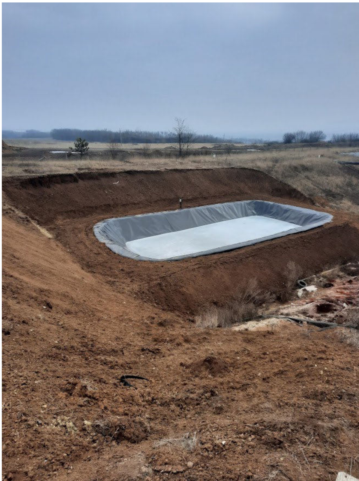
16. ábra Az elkészült csurgalékvíz medence
