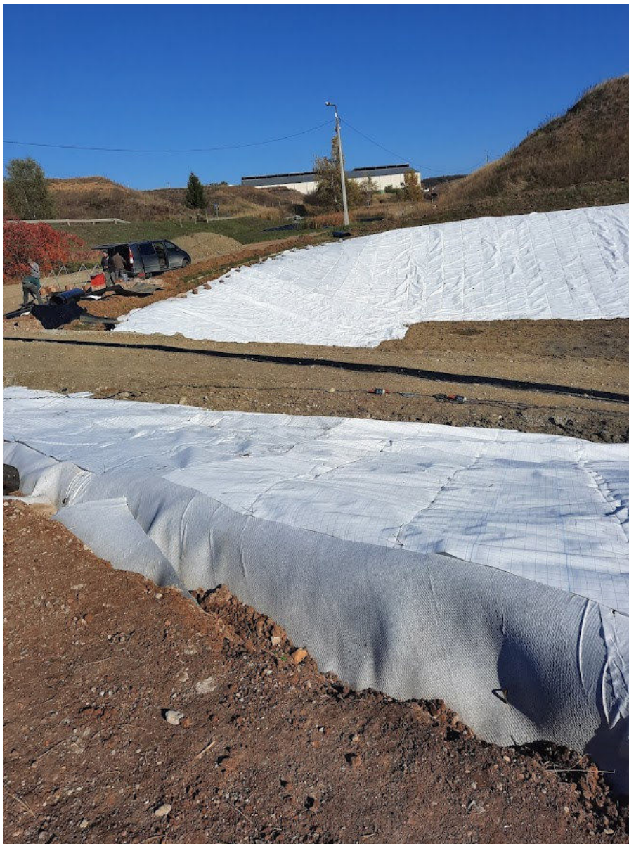
8. ábra A geo-szintetikus szivárgó a második geo-elektromos réteggel
