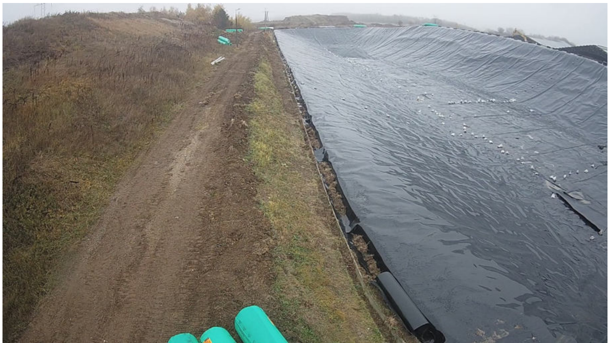
11. ábra A második HDPE réteg terítése_2
