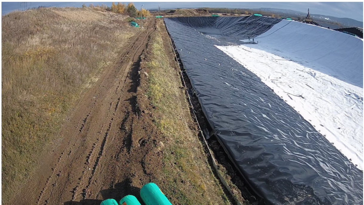
10. ábra A második HDPE réteg terítése_1
