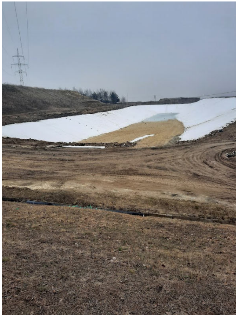
13. ábra A kavicszivárgó beépítése_2
