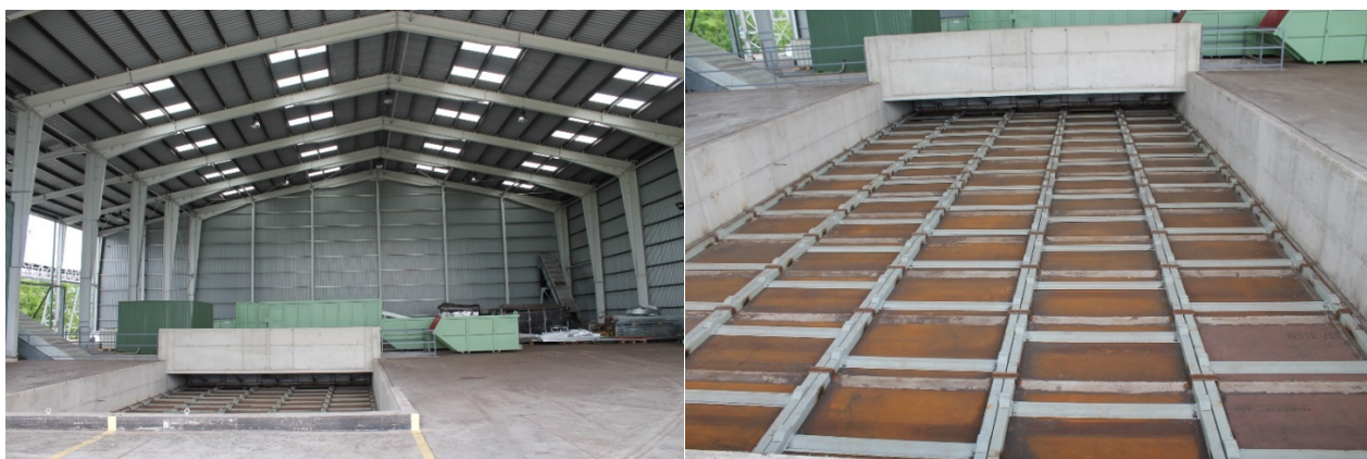
12. ábra: fogadó bunker hidraulikus padlóürítő berendezéssel
