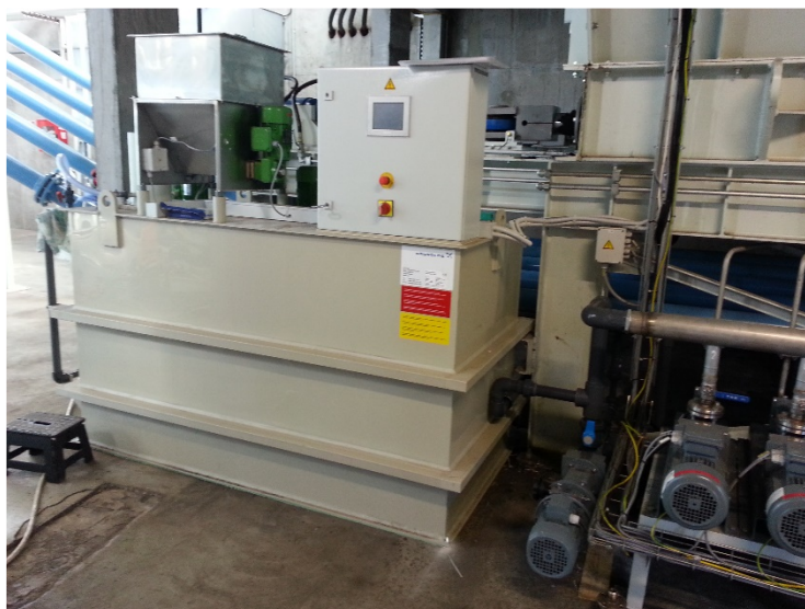
6. ábra: flokkuláló tartály és szivattyúk
