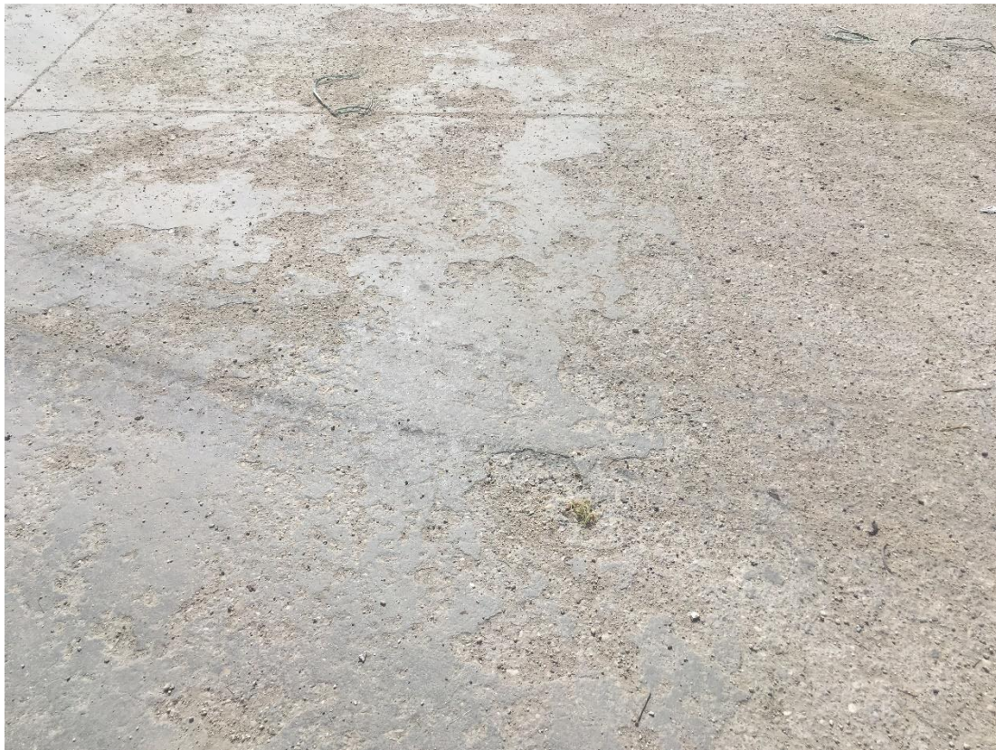
Kopott, hámlott beton felület
