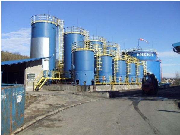
A tartálpark az 5 db 20 m 3 , a 4 db 100 m 3 és az 1500 m 3 -es állóhengeres tartállyal, előtte a 2000 m 2 -es fedett tárolóval
