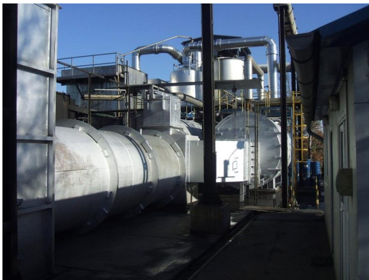
A kép statikus vonal egy részét mutatja. A fekvő, henger alakú műtárgy az utóégető III. fokozat, mögötte az egyik hőhasznosító kazán látható
